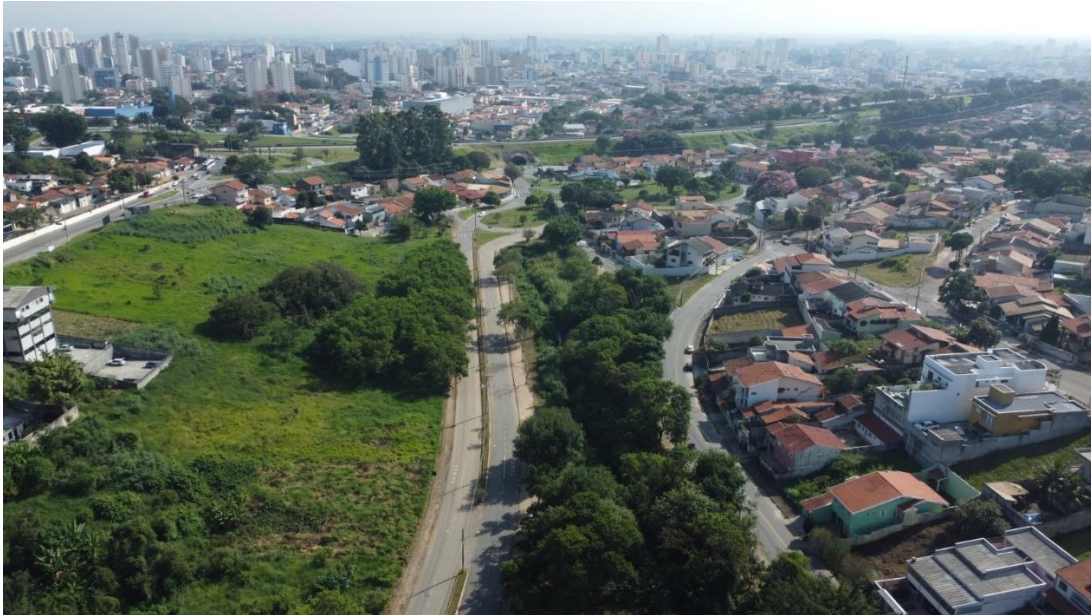
Figura 6. Panorama da área do córrego do convento e arredores – parque linear e bairro.
