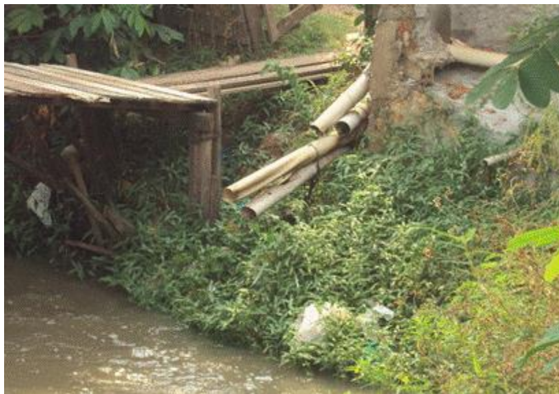
Figura 4. Despejo de efluentes domésticos ao lado de ponte precária de madeira sobre o riacho Bacuri em Imperatriz, MA.
