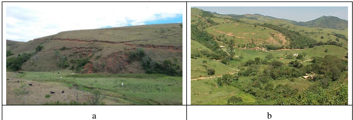
Figura 10 Estradas construídas em propriedades na área rural de Taubaté, SP dando início ao fatiamento e processo de erosão.
