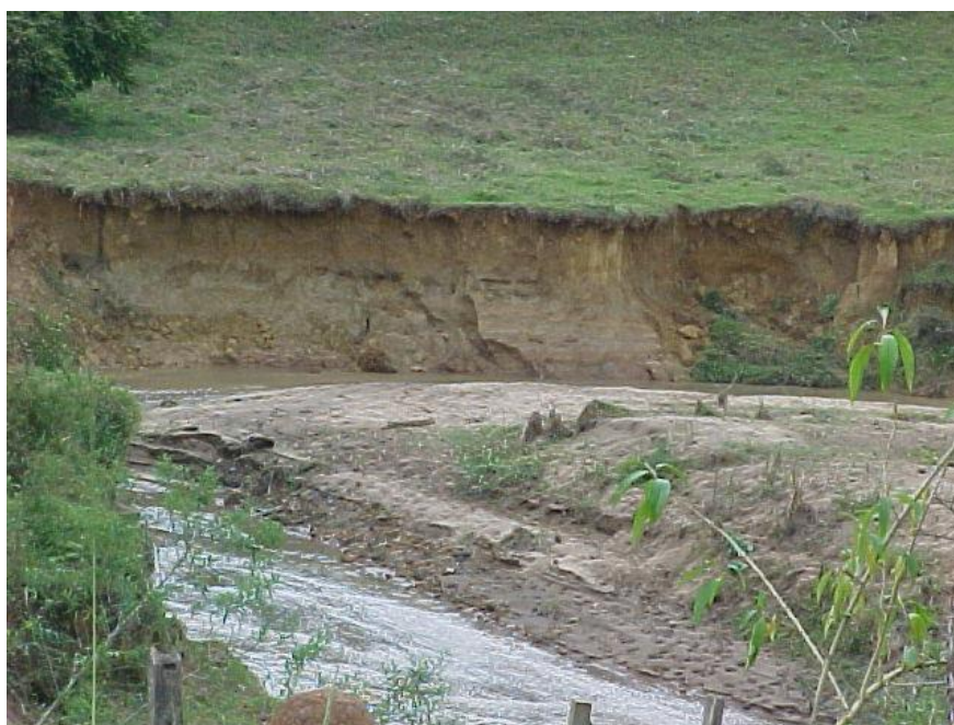
Figura 15. Erosão de margem sem mata ciliar e deposição de sedimento no leito na bacia do rio Una em Taubaté, SP.
