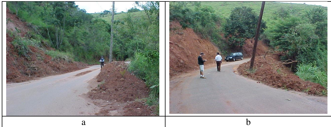
Figura 9. Escorregamento de taludes de estrada rural (a) na bacia do rio Una e deposição ao lado oposto, próximo a rios e córregos (b).
