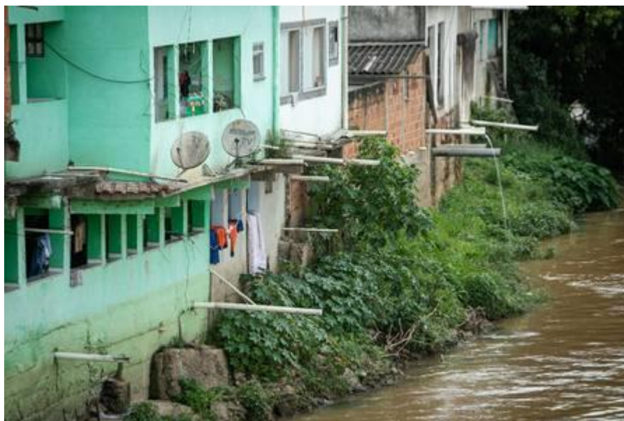
Figura 2: Lançamento de efluentes domésticos e construções e ocupação das margens no município de Queluz-SP.
